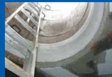
炭素繊維補強ライニングでズレを抑止
